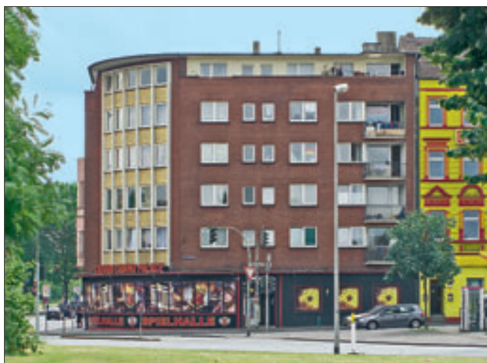
Wohn- und Geschäftshaus in Duisburg, Heerstraße 2, Position 27
