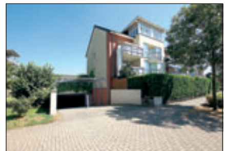
Zufahrt zur Tiefgarage
