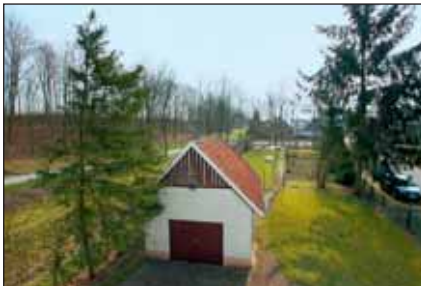
Grundstücksansicht mit Nebengebäude am Damm
