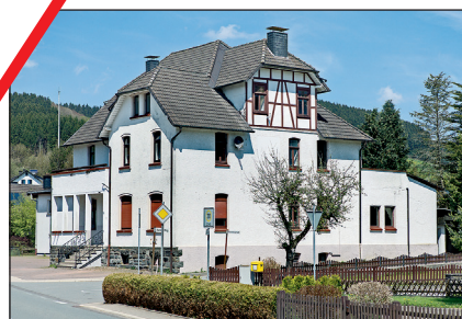
Blick auf das Objekt
