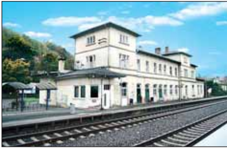
Objektansicht vom Bahnsteig
