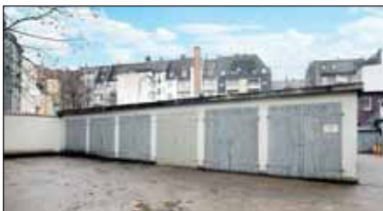
Garagen im Innenhof
