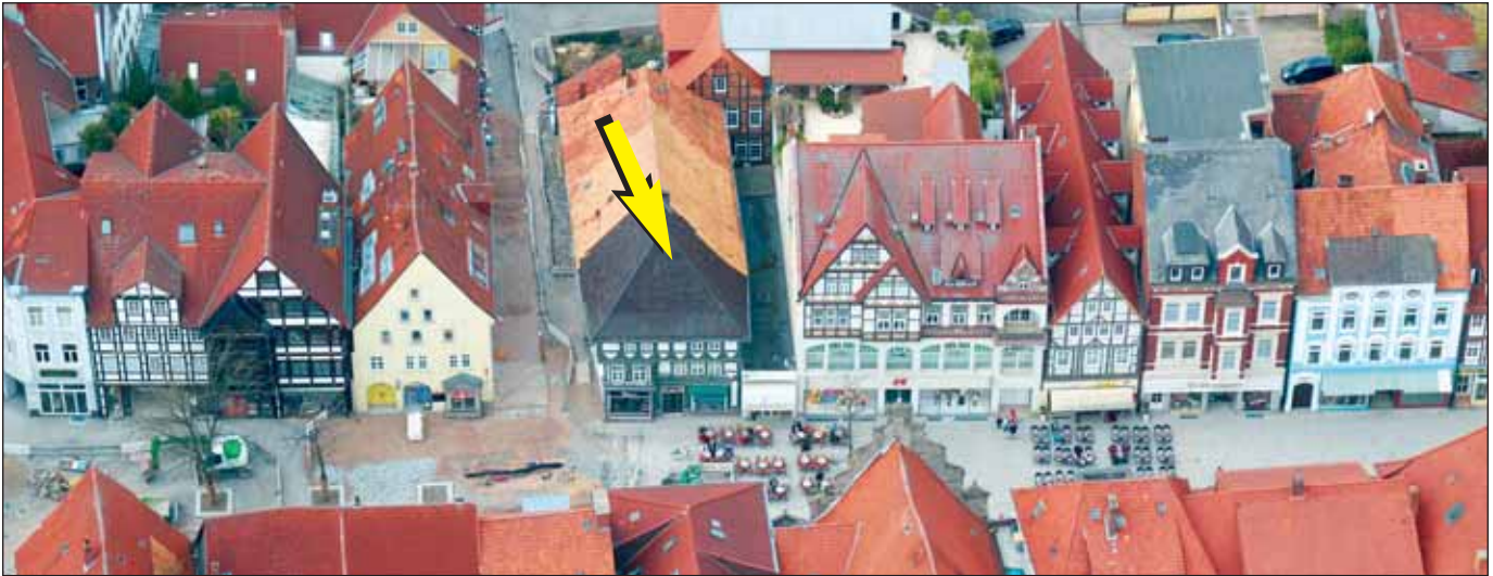
Fußgängerzone Bäckerstraße am Objekt
