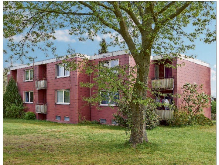
Mehrfamilienhaus in 29565 Wriedel, Ulenfeldweg 9, Position 48
