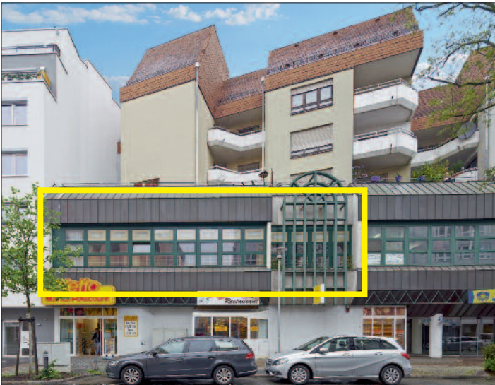
Gewerbeeinheit mit Tiefgaragenstellplätzen in 71032 Böblingen, Stuttgarter Straße 9/Querstraße 3, Position 54
