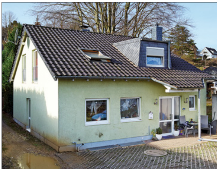
Einfamilienhaus in Bonn, Position 42
