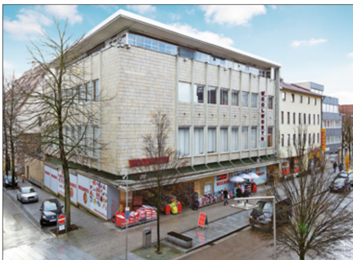
Einzelhandels- und Gewerbeobjekt in Göppingen, Position 31
