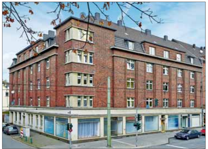
Duisburg OT Marxloh, Kaiser-Friedrich-Straße 31/Roonstraße 72, Position 4
