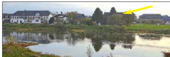
Blick über die Weser zum Objekt
