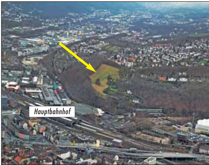
Blick auf das Grundstück und den benachbarten Hauptbahnhof
