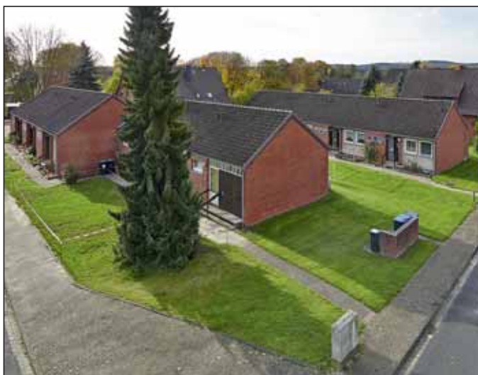
Grundstücksansicht mit Reihenhäusern
