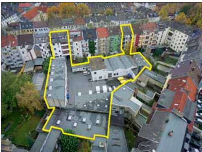
Blick auf den Hof und die Häuser Braunschweiger Straße 20 und 12
