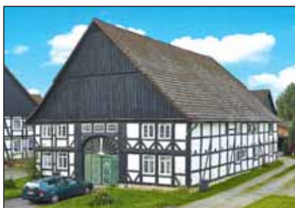
Blick auf das Objekt
