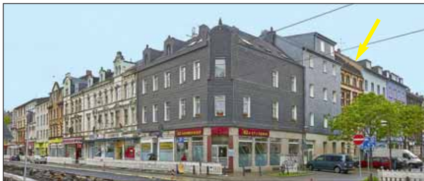
Blick von der Wanheimer Straße auf das Objekt
