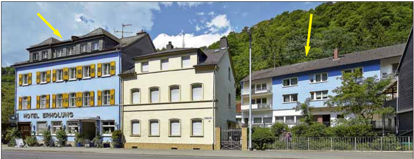
Straßenansicht des Hotels (Pfeile) mit Nachbarschaft
