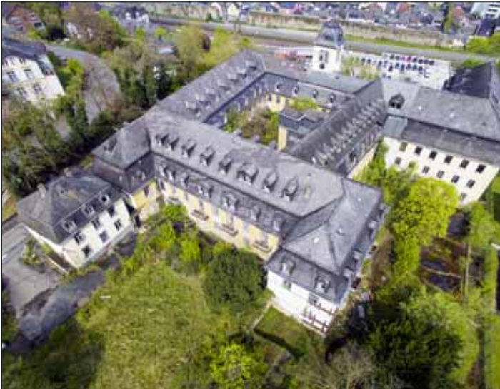
Wohnungsbauprojekt in Boppard am Rhein, Position 28
