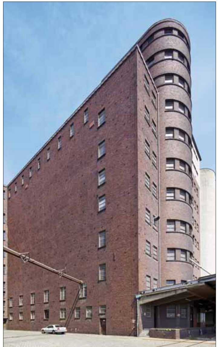
Silgebäude in Mannheim - Industriehafen, Position 55
