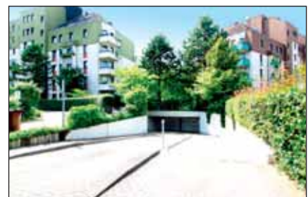
Zufahrt zur Tiefgarage
