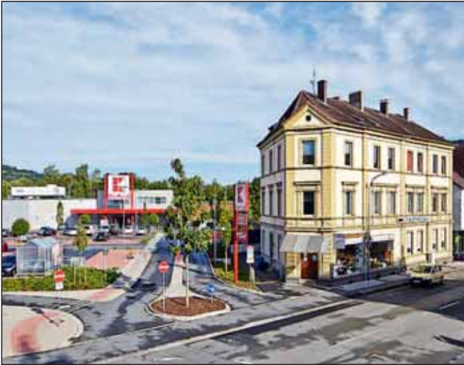
Blick auf das Objekt und die Zufahrt zum Kaufland
