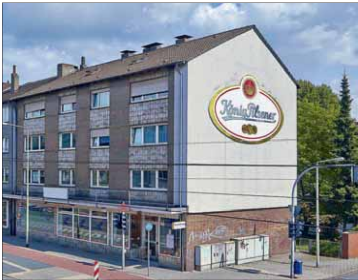
Wohn- und Geschäftshaus in 47139 Duisburg, Position 37
