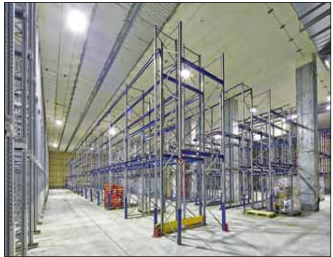
Innenansicht Kühlhalle mit Regalsystemen
