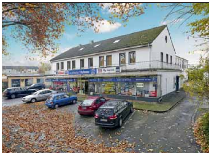
Wohn- und Geschäftshaus mit Garagengebäude in Duisburg, Position 10
