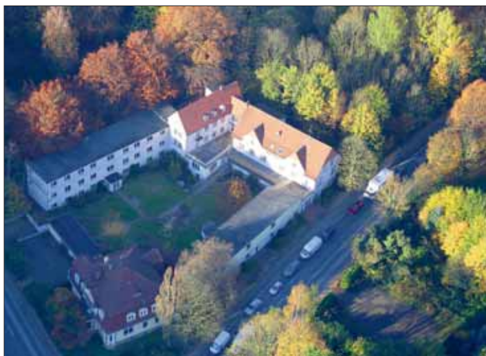
Ehemaliges Pflegeheim mit Anbauten in Rinteln, Position 43
