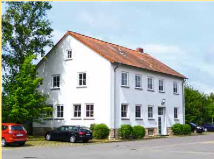
Bürogebäude in Uelzen - Pos. 11
